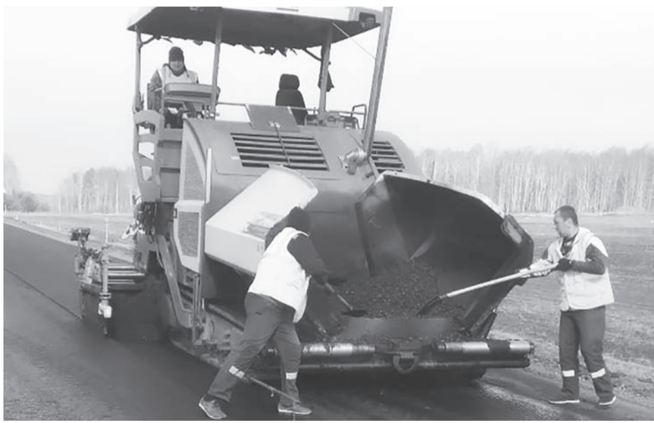
Идёт укладка выравнивающего слоя асфальта.
