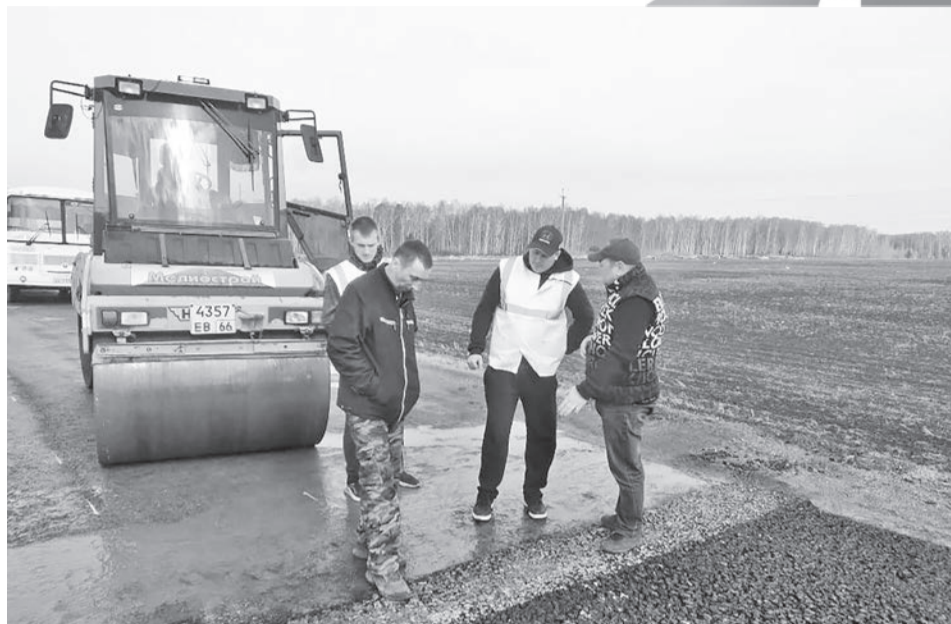
Прораб Сергей Епишин обсуждает рабочие моменты строительства.
